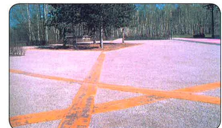
Opstibning på beton
