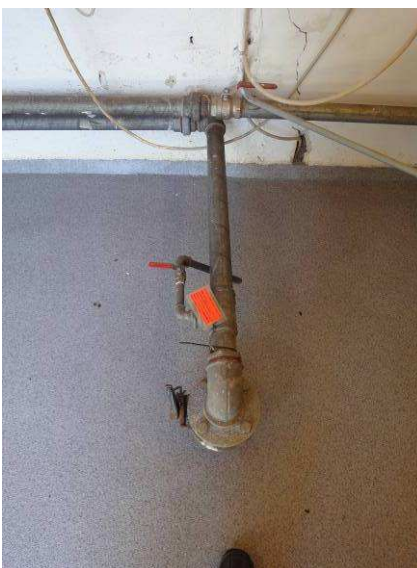
Prøvetagningshane for råvand med DGU. nr.
