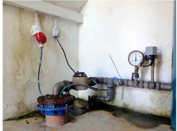
Boring med vandmåler
