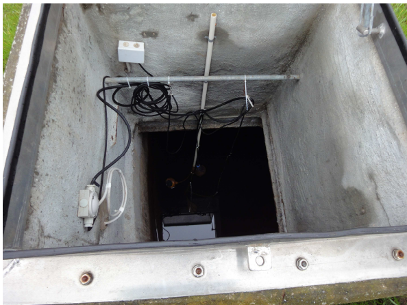
Adgang til rentvandsbeholder
