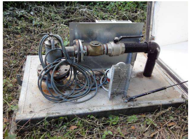
Boring 3 på sydlige kildeplads
