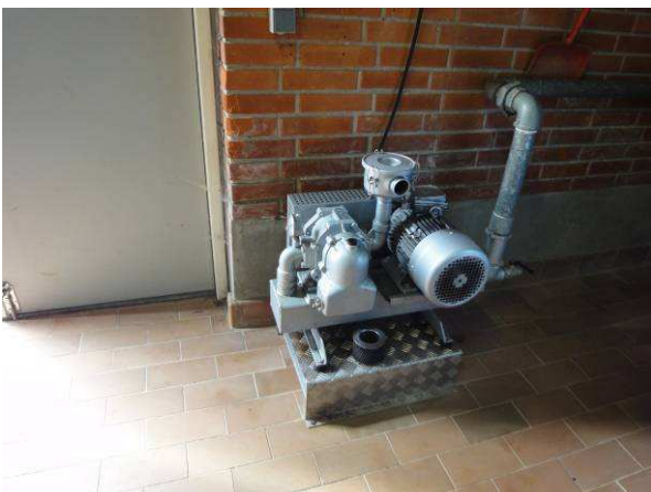
Belufterblæser til reaktionsbassin
