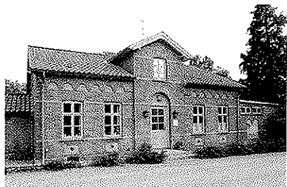
Park Alle 5, Trustrup, opført o. 1910. Husets facade er præget af historicismens rige brug af dekorative elementer såsom facadebånd i puds, brystningsblændinger under vinduerne og trempel med en romansk buefrise. Taghældningen og udhængt antyder, at huset måske har haft skifertag.
