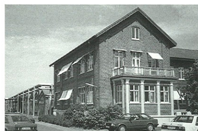
Administrationsbygningen til Dampvæveriet og i baggrunden ældre shedtagsbygninger, næsten skjult af tekniske ledningsanlæg.
