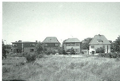
Storvillaerne ved Kystvej vender fronten mod havet for at opfange stedets herlighedsværdi, havudsigten.
