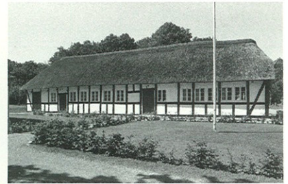
Hr. Søren's Hus i Vejlby. En istandsat ældre bindingsværksbygning fra 1700-tallet med gennemstukne bjælkeender og højt styrtrum.
