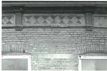
Dekorativ frise med mønstermurværk under gesimsen på den tidligere rugbrødsfabrik, Østerbrogade 27, opført o. 1905.
