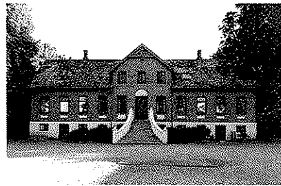
Stuehuset til Djursgård, Slemmingvej 15, opført o. 1860. Markant hus præget af historicismen. Med imponerende trappe op til indgangsparti afsluttet med gavlkvist. Fine snedkerværker over gavle og kviste. Facaden er dekoreret med pudsede brystblændinger.
