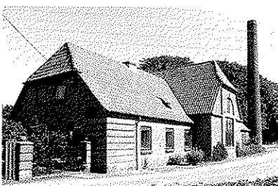
Trustrup Mejeri, Park Alle 2, opført i 1927. Bygningen er med Bedre Byggeskik som forbillede opført med røde teglstensfacader, murede stik over dør- og vinduesåbninger, og brede kvadermurede hjørnelisener. Den gavlvendte mejerihal med det store vindue og skorstenen er typiske kendetegn på disse mejeribygninger.
