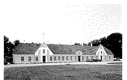
Stuehus til Lyngdal, Århusvej 115, opført o. 1850 som kampestensbygning og ombygget til nuværende udseende i 1910. Ved ombygningen blev facaderne pudset, og de to risalitter med barokprægede frontkviste og frontonen i midten blev tilføjet.
