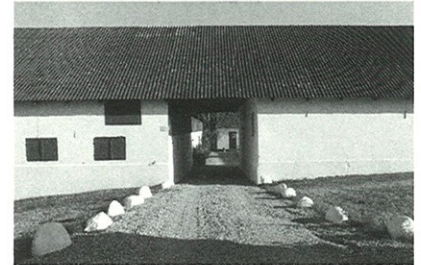
Det helstøbte gårdanlæg til Nymann Gård, Nymandsvej 18, med karakteristisk gennemkørselsport, der flugter med udlængen.
