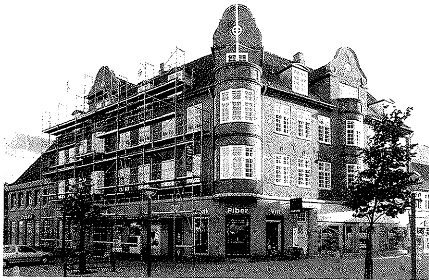
Djursborg, Storegade 1, er opført i 1919 efter tegninger af arkitekt M.C. Thoft. Bygningen er et smukt eksempel på dansk håndværkertradition i det murede byggeri og som reaktion på de udenlandske strømninger ved århundredskiftet. Bygningen har klassiske stiltræk, og de dekorative elementer er enkle og i høj grad baseret på egenkarakteren af byggematerialerne, teglsten, puds og granit. Den nye butiksfacade bryder med bygningens ellers meget sikre fagrytme.
