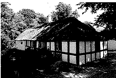
Søren Quists Vej 13, opført omkring år 1800. Det lave hus har helvalmet stråtag, og facaderne viser de byggeperioder som mange huse har undergået, dels bindingsværk fra husets ældre periode og dels tilbygning i grundmur.
