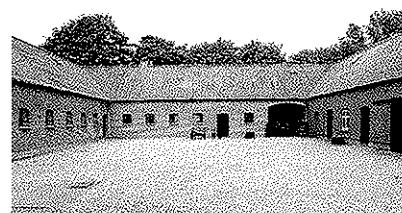
Udlængerne til Lille Lykkesholm, Fuglebækvej 19, er opført som et samlet gårdanlæg i 1930'erne i røde teglsten, med trempel og gode håndværksmæssige detaljer. God helhed.
