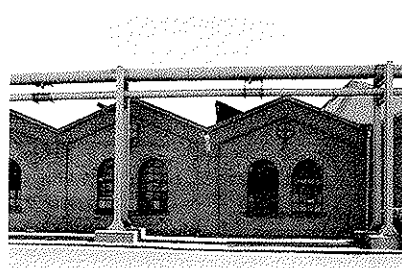
Ældre væveribygning fra 1912 til Grenå Dampvæveri på Østerbrogade. Den lave fabriksbygning er opført med shedtag, der giver mulighed for jævnt dagslysindtag i den store hal.
