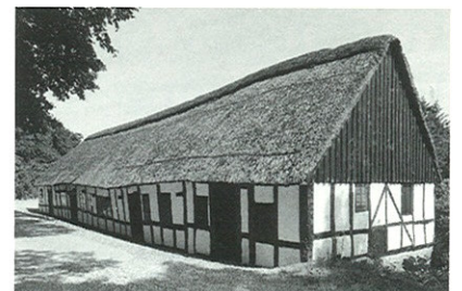
En vigtig del af Katholms kulturhistorie er de mange arbejderboliger, lyste jendomme og øvrige bygninger, der hører til herregården. Her ses den istandsatte vandmølle i bindingsværk fra 1700-tallet, beliggende øst for hovedbygningen.
