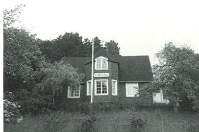
Bakkebo, Gennem Landet 26, opført ca. 1916 som sommerhus i let træ-konstruktion med træspånbeklædte facader og tagpap på taget.
