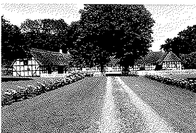
Hammelev Præstegård, Hammelevvej 62, fra o. 1765. Fredet. Bygningen er opført med høje facadestolper, hvorigennem loftbjælkerne oprindeligt var tappet. Senere er bjælkelaget hævet.
