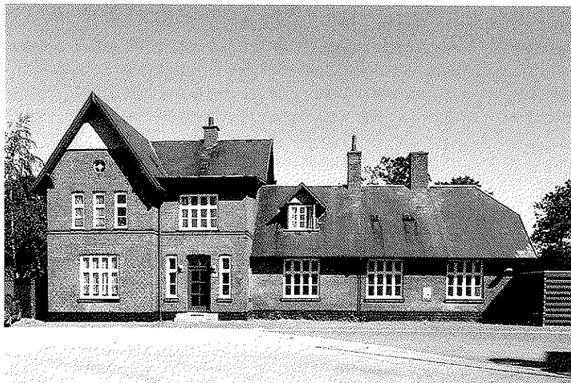
Trustrup Station, Stationsgade 22, opført i 1876, fremstår i det væsentlige som ved opførelsen, med enkle murstensflader og naturskifertag med stort udhæng. Spærrenderne og tagåsene er dekoreret og giver bygningen en let karakter i schweizerstil.
