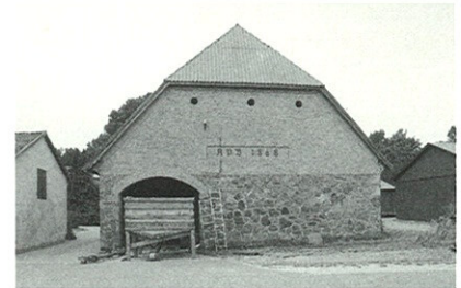
Agerumslade til Hoedgård, Hoedvej 52, opført o. 1868 i kløvet kampesten med fin sammenmuring af de uregelmæssige sten.
