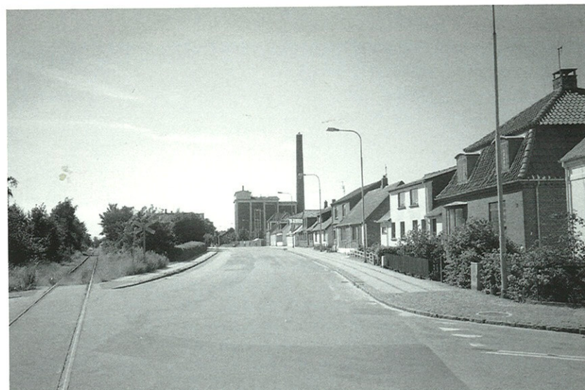
I kraft af sin størrelse og placering i svinget er dampværket blevet et vigtigt orienteringspunkt på den lange vejstrækning.
