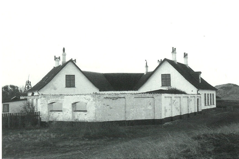
Den fredede fyrgård ved Anholt fyr er opført i en særpræget trapezform omkring en indre lukket gård og med yderligere to muomkransede gårde, der har til formål at holde sandet ude.
