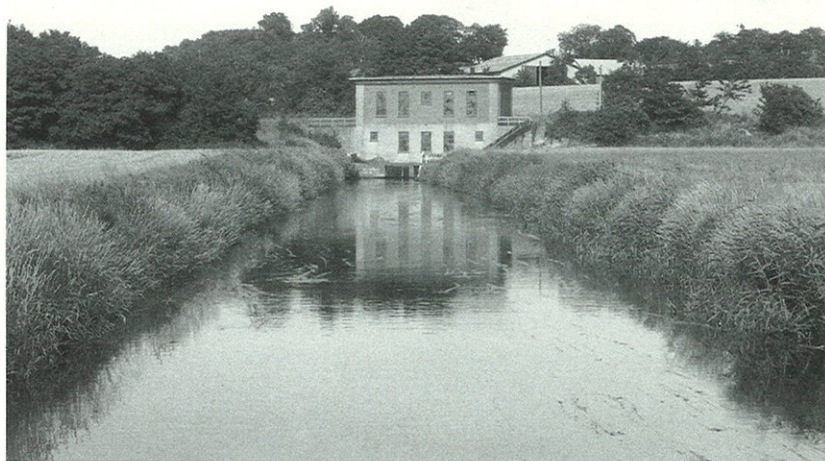
Indløbskanalen til pumpestationen ved Enslev. En arkitektonisk og landskabelig manifestation af kulturlandskabet efter forvandling.
