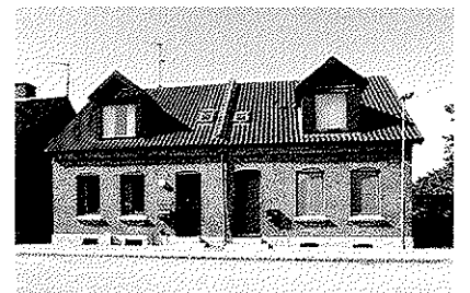
Nygade 21-23, opført 1906. Omkring Nygade og Østerbrogade opførtes i det første årti i dette århundrede en række beskedne småhuse som enkelt- eller dobbelthuse. Flere bygningstyper, som går igen, antyder, at bygningerne er opført efter fælles tegninger.
