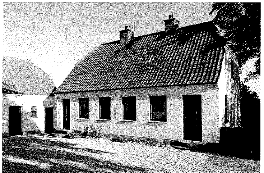
Velbevaret husmandssted fra 1930'erne på Stensmarkvej 32. Ved opførelsen af husmandsbrugene blev der i stor udstrækning anvendt standardtegninger, ofte med forbillede i Bedre Byggeskik. De mange spredte husmandssteder fik derved fælles karaktertræk.
