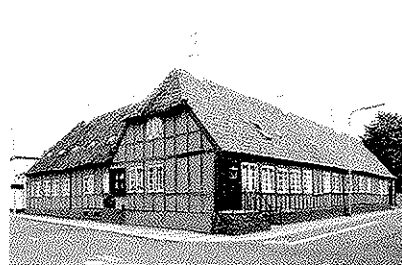
Lillegade 50 er opført i 1768 og væsentligt ombygget omkring 1820. I facaden mod Lillegade har bygningen dobbelttømmer i hvert fag i underfacaden, mens facaden mod Vestbanegade alene har enkelttømmer, der er det normale i gadens øvrige bindingsværksbygninger.
