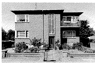
Århusvej 88, opført 1937. Funkishus i to etager med karakteristiske hjørnevinduer, gennemgående højt vindue i trapperummet, udhængende altan og bredt tagudhæng samt tagpapdækning på det svagt hældende tag.
