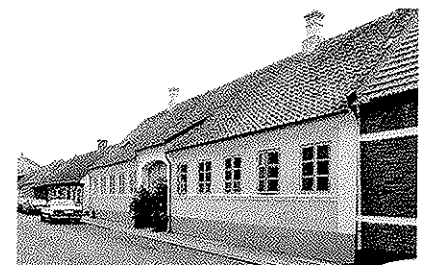
Storegade 63, opført i 1852, er et forment eksempel på de tidligere grundmurede huse i gaden. Den pudsede facade har gennemgående sælbænkgesims under vinduerne og afsluttes med en trukket hovedgesims. Huset har flade, pudsede hjørnelisener, som ses på flere huse fra denne tid.
