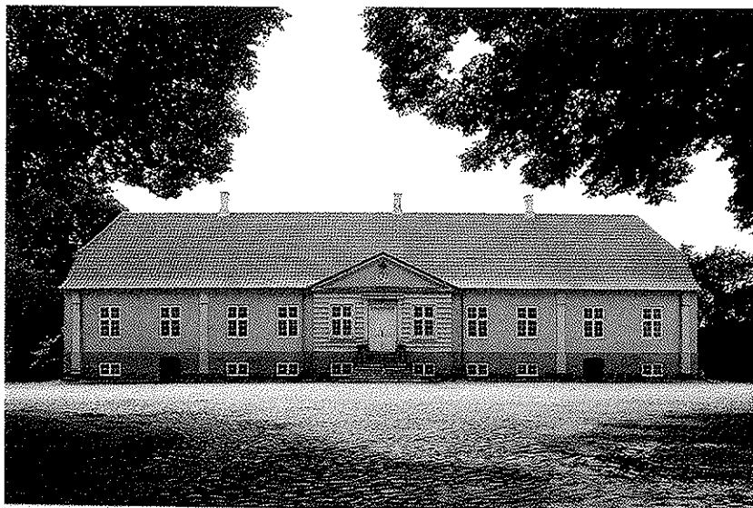
Lykkesholm er et stramt nyklassicistisk gårdanlæg, opført 1804 og tilskrevet bygmester Just Møller. Hovedbygningen, der er fredet, er i 11 fag, og midterrisalit med indgangsparti i tre fag med pilastre med triglyfkapitæler, kronet af en lav gavlfronton. Som helhed et velholdt gårdanlæg af stor kulturhistorisk værdi.
