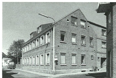
Eksempel på bygning med middel bevaringsværdi.
