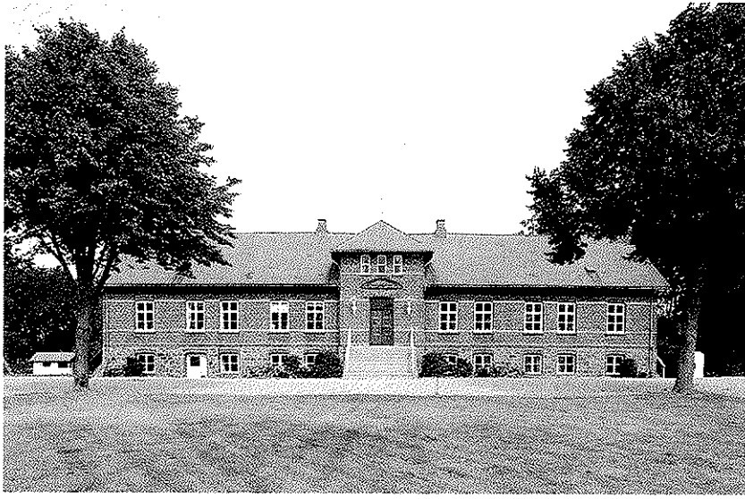
Stuehuset til Nygård, Nygårdvej 47, opført omkring 1887 med forbillede i den italienske storvilla. Facadens strenge symmetri omkring det fremspringende midterparti med hovedtrappen er underdelt med vinduernes præcise rytme. Dekoreret med pudsede bånd i den røde teglstensfacade. Den høje kælder er opmuret af tilhuggede kampesten.
