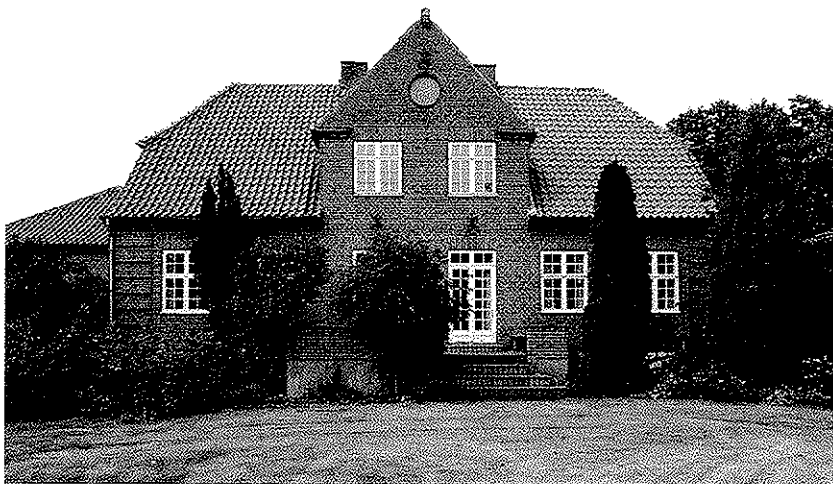
Grønland 24, opført 1925 af Djurslands Landboforening som et trefløjet anlæg med bolig, undervisningsbygning og udhus for landbrugskonsulenten. Det trefløjede bygningsanlæg er en usædvanligt velbevaret bebyggelse i Bedre Byggeskikstil i meget original tilstand og med meget fine bygningsdetaljer. Proportioner og detaljering af facaderne svarer til deres betydning, mens en enkel, gedigen og traditionel håndværksmæssig udførelse sikrer helhedskarakteren.
