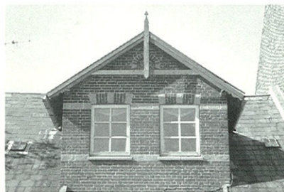
Gavlkvist på Østerbrogade 23 med træværksdekoration, pudsede facadebånd og pudsede slutsten i stikket over vinduerne, som er karakteristisk for mange historicistiske huse.
