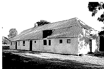
Dalsagervej 8, opført o. 1879, er et velbevaret og sjældent husmandssted med stald, beboelse og udhus i forlængelse af hinanden. Den store gavlvalme er karakteristisk for de ældre traditionelle landbygninger.
