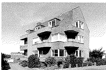
Rosengade 3, opført 1937. Med påvirkning fra den internationale funktionalisme opstod en dansk tradition, hvor murstensbyggeriet udformedes med funktionalismens kendetegn, såsom hjørnevinduer, rummelige udhængende altaner med afrundet muret brystning og støbt baldakin over hovedindgangen.
