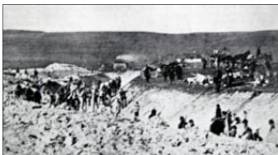
Arbejdshold i gang med Sydkanalen der nogle steder måtte hugges ud i undergrundens kalk. I perioder var op til 600 mand i gang med anlagsarbejdet på og omkring kanalerne. Gengivet efter Bygd, 1982.
