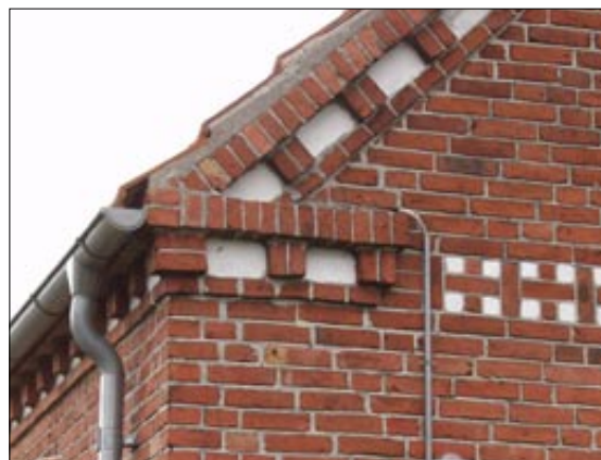
Dekorative detaljer i den murede gesims.
