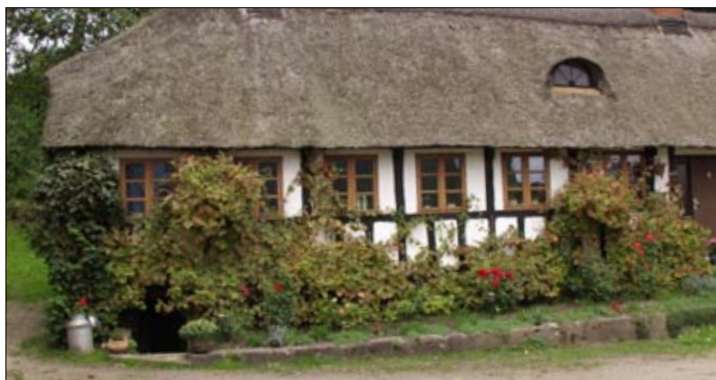
Askhøjvej 62. Adgangen til den beskedne kælder sker udefra.
