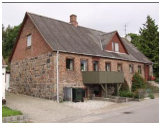
Askhøjvej 68. Bygningen har tidligere været købmændsbutik før købmanden flyttede over gaden til nr. 55 (ovenfor). Bygningen er opført omkring 1900 med høj kælder i kampesten. Den nederste del af gavlen er ligeledes i kampesten. Arbejdet kan være udført af den lokale kampestensmurer?
