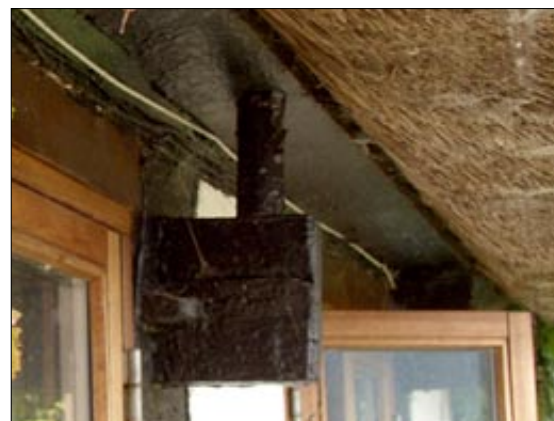
Askhøjvej 62. Bygningskulturen er også de mange (ofte egnskarakteristiske) detaljer, som der skal værnes om. Understøtningen af tagudhænget hviler på gennemstikningen. Formodentlig en oprindelig detalje.
