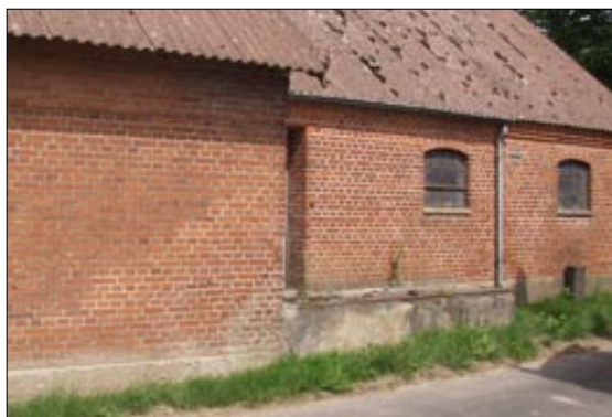
Kare Engvej 6. Dansk landbrugsbyggeri fra mellemkrigstiden. Solidt og gedigent med støbt sokkel og røde teglsten. Den lille læsserampe med jernforstærket kant vidner om den epoke, hvor mælken blev transporteret til og fra mejeriet i jungler.
