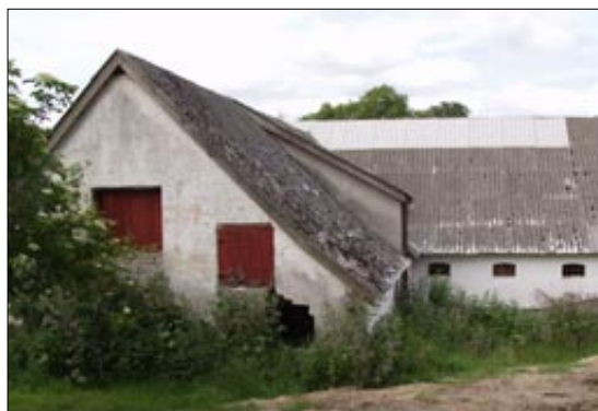
Kare Engvej 5. Den beskedne stald og lade til et af byens husmandsbrug. Stalden er en vigtig brik i bevarelsen af gaderummet på Kare Engvej.
