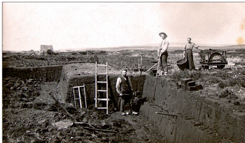
Tørvegravning på gården »Strømlund«, Hovlinen 10, i 1911. I baggrunden er klynerne, de stukne tørv, lagt op til tørring, men faktisk er banesporet, der anes i højre side af billedet, allerede etableret.
