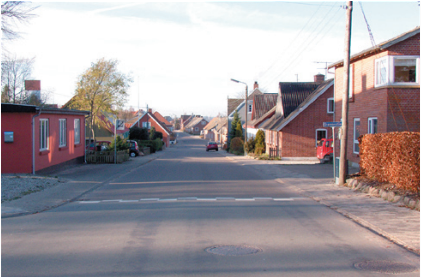
Hovedgaden gennem Øster Alling er i dag præget af små et-plans byhuse opført i første halvdel af det 20. århundrede. Indtil midten af 1800-tallet lå byens gårde på nordsiden af vejen (billedets højre side) mens byens småhuse især lå på sydsiden.
