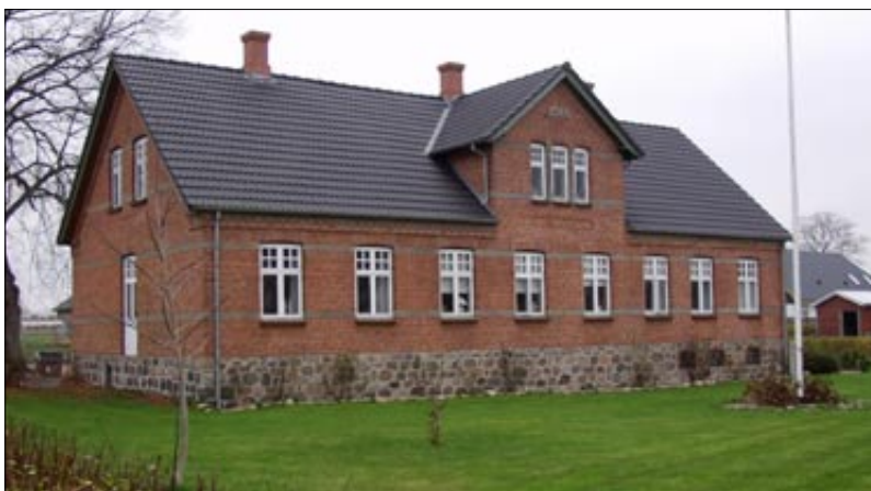
Stuehuset til gården Birkedommervej 19. Bygningen er fra 1914. Gedigent og smukt rødstensbyggeri på sokkel af uregelmæssige kampesten. Vandrette murbånd i grå cement. Huset har fået et nyere men velvalgt tag, som er med til at understrege bygningens karakter. De firerammede vinduer med små sprosser i de øverste rammer er et godt eksempel på, hvor meget den originale vinduestype betyder for det samlede indtryk. Her er der tydeligvis både fornemmelse for helhed og detalje i vedligeholdelsen.
