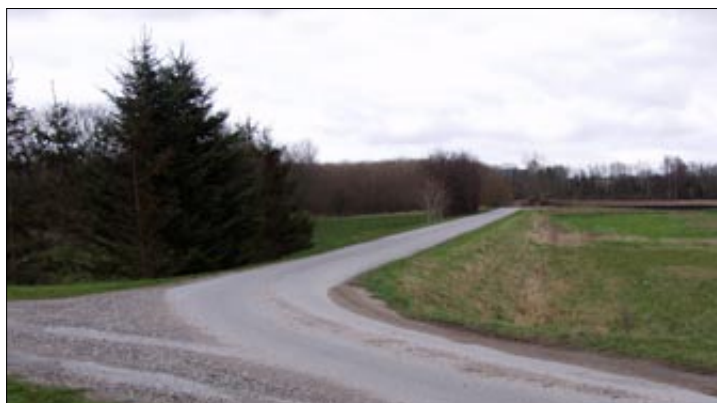
Den bevarede stump banedæmning, som nu er vej.
