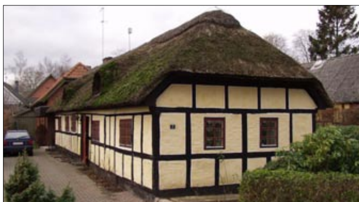
Smukt ældre bindingsværkshus opført som stuehus til en for længst udflyttet gård. Husets meget beskedne dybde – omkring 5 m – indikerer, at der er tale om en gammel bygning. Den nuværende ejer har oplyst, at huset ved overtagelsen i 1965 havde en tykmavet bagerovn, som ragede ud af husets side og stenpikning i køkken og baggang.
