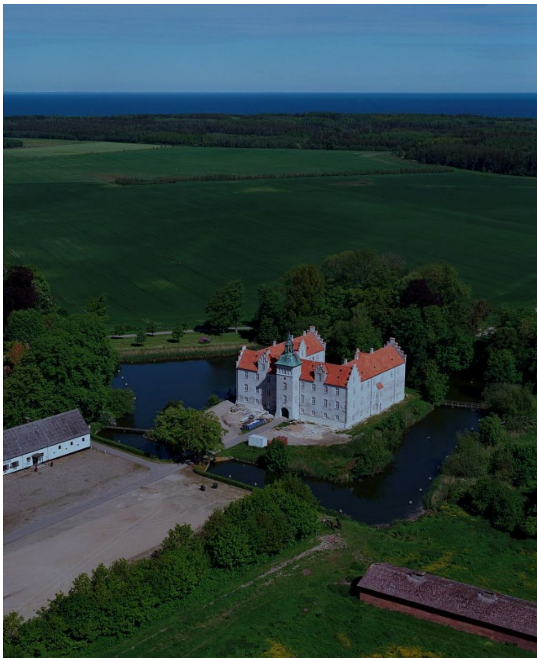
Meilgård under restaurering efter brand.
